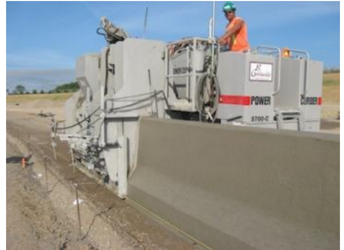
Fig. 9. Ndërtimi i barrierës rrugore prej betonit në një segment rrugor.
