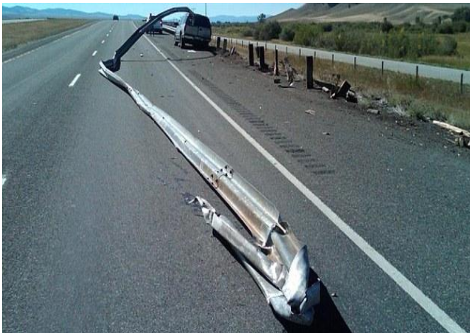
Fig. 3. Dëmtimi i barrierës rrugore prej çeliku, gjatë aksidentit në komunikacion.
